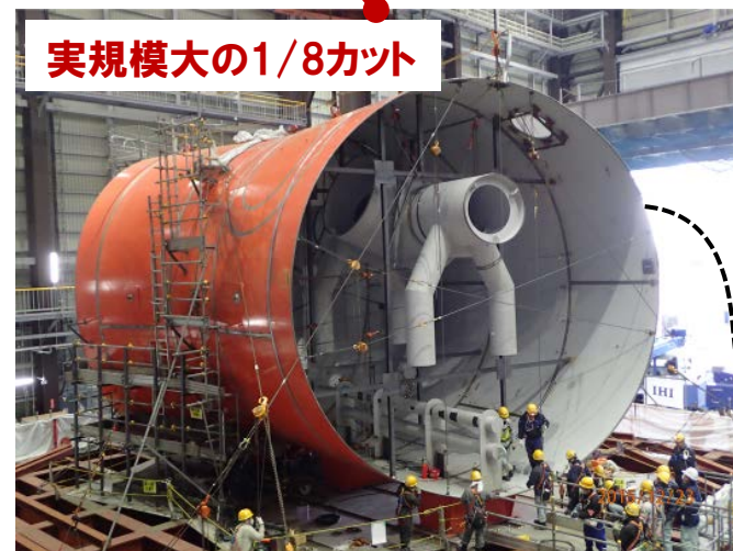
原子炉格納容器下部の実規模試験体 写真引用 [IRID Webページ]
