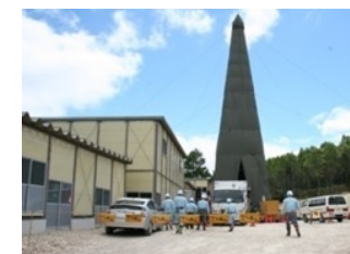
地上からのボーリング調査
