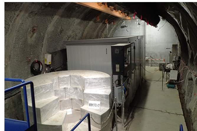
350m調査坑道 試験坑道4
