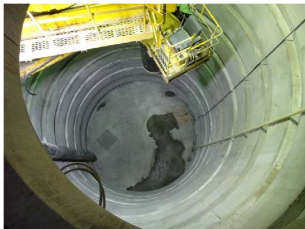
西立坑 (平成26年3月26日撮影)
