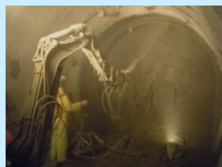
低アルカリ性コンクリート材料の試験
