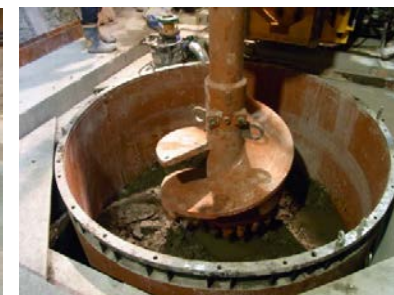
試験孔の掘削中の様子
