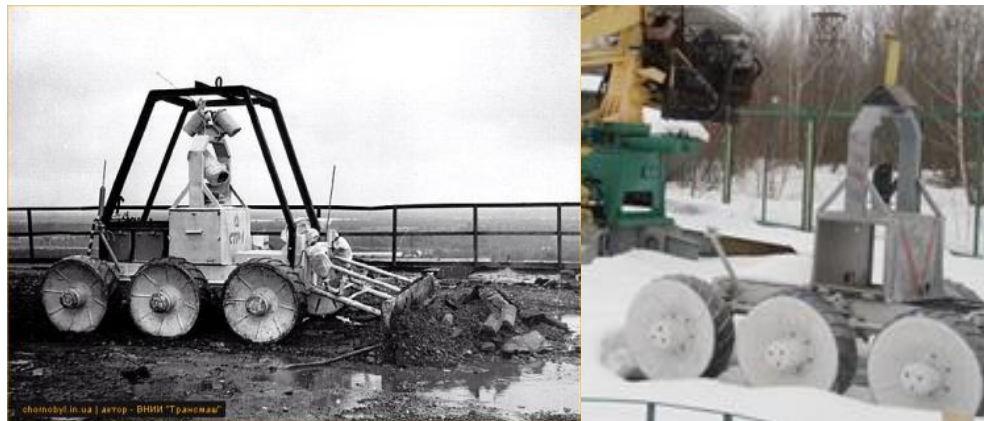
汚染瓦礫を除去するSTR-1(左)とその残骸(川妻伸二氏 提供)
